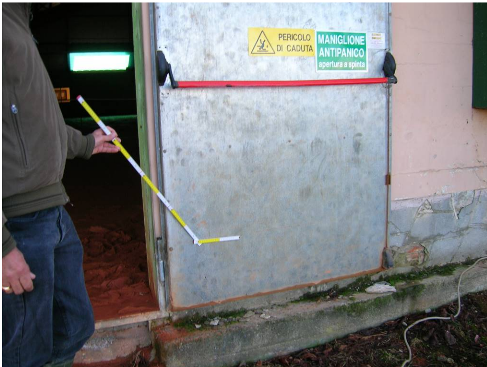
Punto H1 : quota terreno 251,25 (quota acqua evento 2016: 0,65 m = 251,90)
