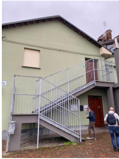
Scala di collegamento
